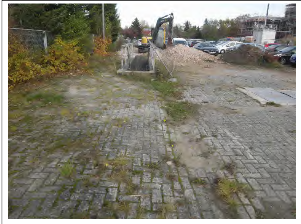
Foto 5: Blick zum Treppenabgang der Abwasserpumpstation (November 2018).
