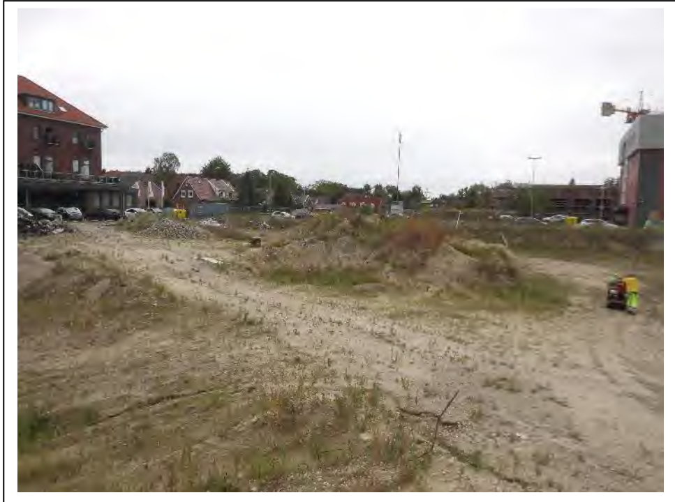
Foto 1: Baugrube zum Zeitpunkt der Ausführung der Bohrungen (August 2018).
