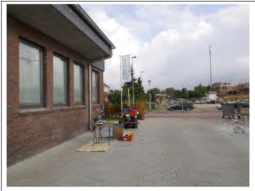
Foto 2: Ausführung der Bohrung KRB 21 (August 2018).
